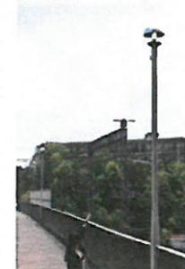
ネットワークで結ばれたLED街灯。無線による遠隔操作で照度などを調節できる（1日午前10時35分、木津川市相楽台）
