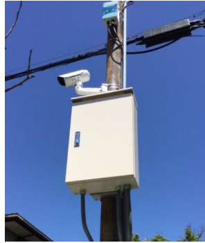
木津川市設置例
