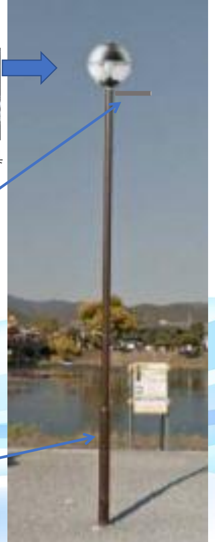
ポールは既存のものを使用 灯具交換 (密閉型に変更)
